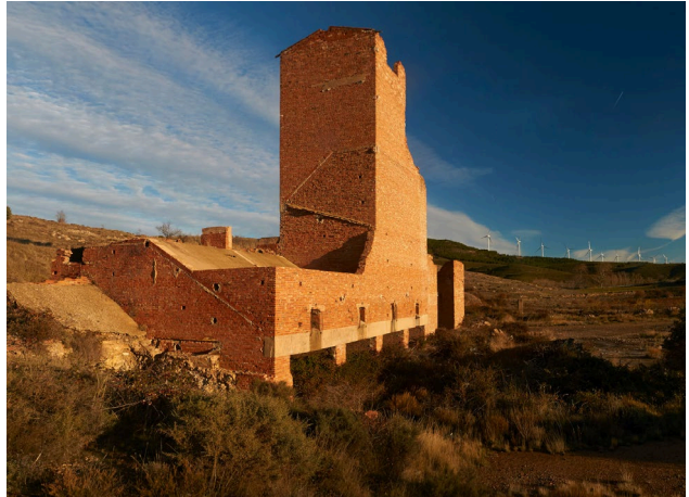
Figura 1.- Fotografía del estado actual del edificio de selección y cargadero situado en la concesión La Mari Pili. Año 2019. Autor Carlos Ezquerro Palacios (Colección particular Carlos Ezquerro Palacios).
